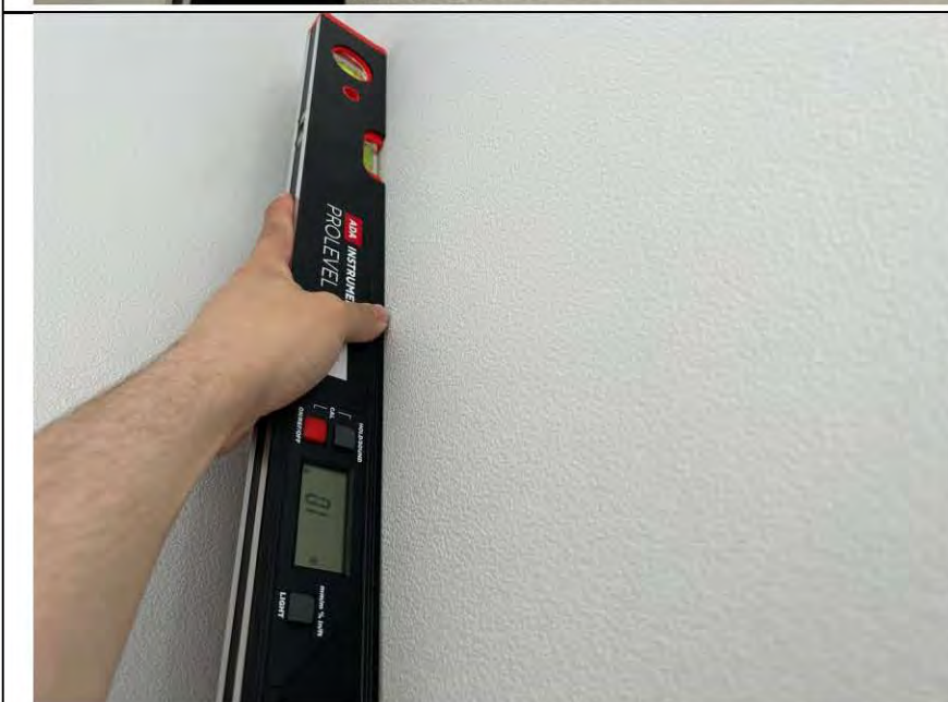
Фото №15. Измерение уровня стен в лоджии.
