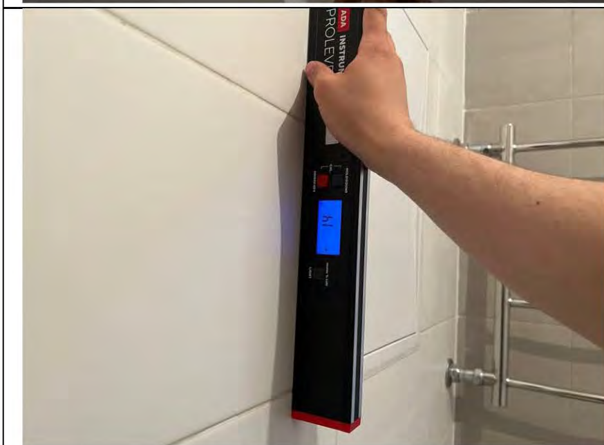
Фото №24. Измерение уровня стен в ванной комнате.
