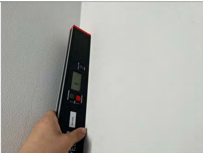
Фото №12. Измерение уровня стен в спальне.
